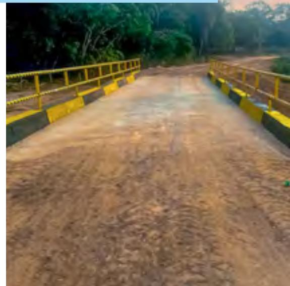
Foi construída uma **ponte de concreto armado**, com **20 metros de comprimento**, sobre o **Córrego do Barbeiro**, na **Vicinal 3**, em substituição à antiga ponte de madeira, no município de **São João do Araguaia**, com um investimento de **R\$ 3 milhões**.
