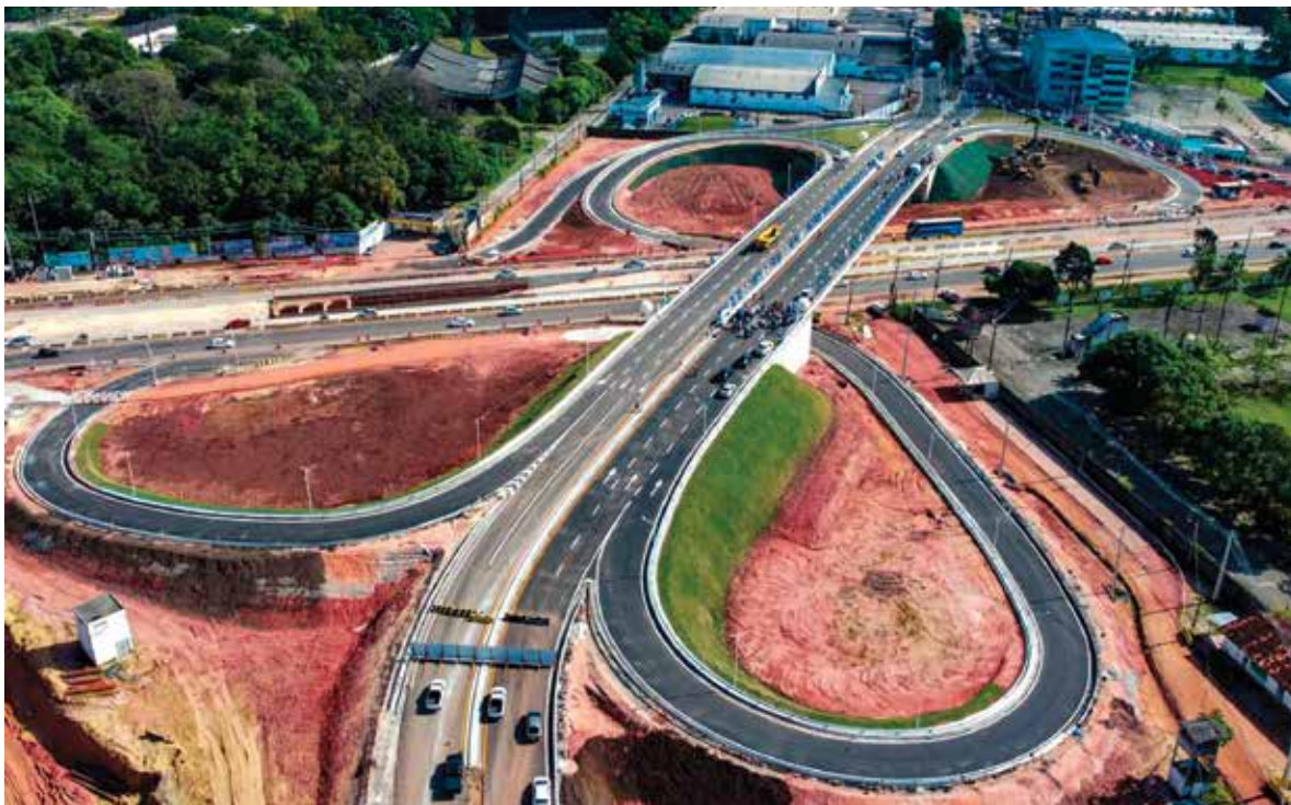
Novo viaduto na BR-316 com Av. Ananin e novas passarelas na BR-316, em Ananindeua.
