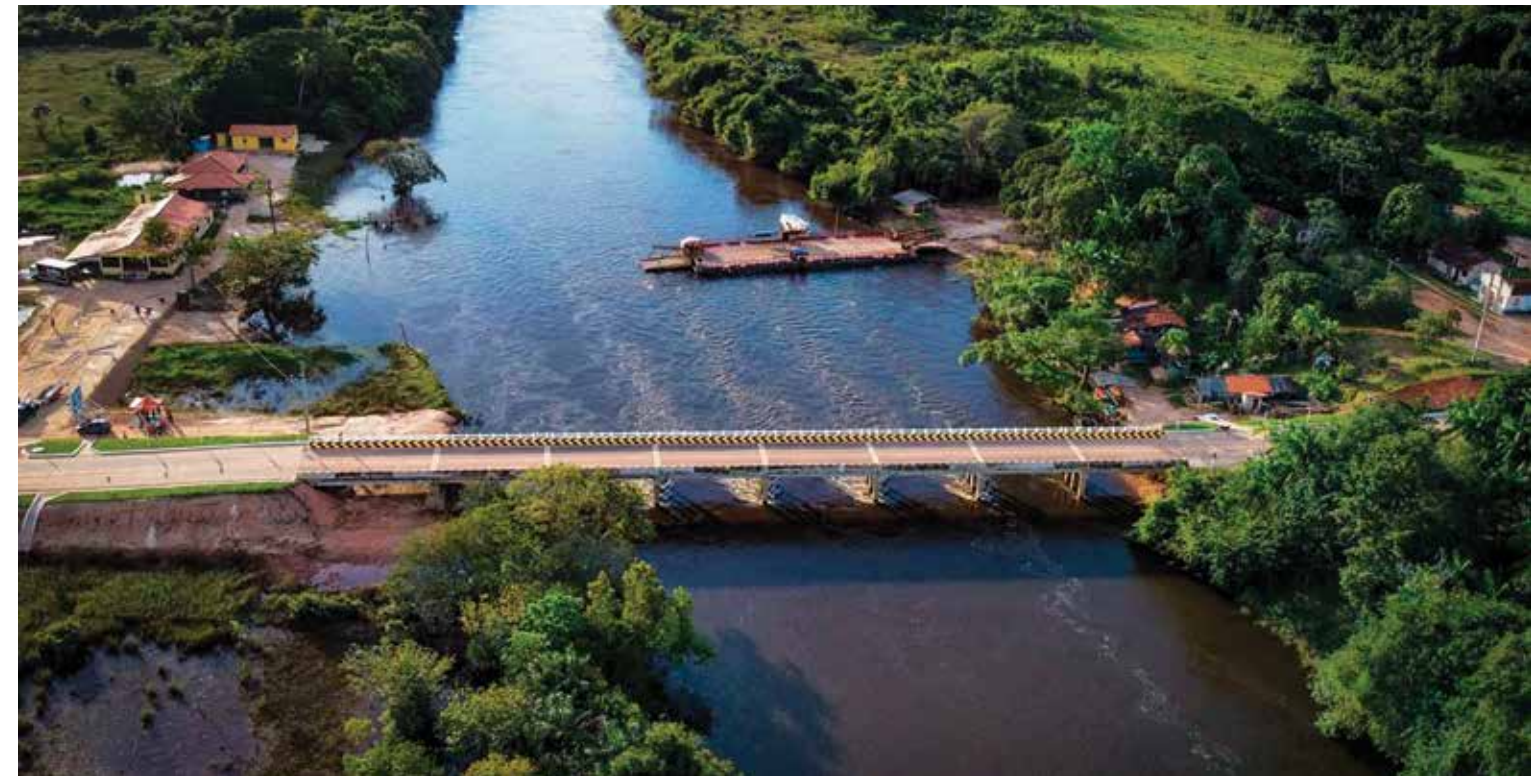
Construção de ponte de concreto armado com 100 metros de comprimento sobre o Rio Guamá na PA-253, que liga Capitão Poço a Santa Luzia.
