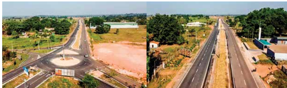
Conclusão da duplicação de 2,8 quilômetros da PA-279 até o aeroporto de Xinguara e da reconstrução do lote 1, de 70 quilômetros, que conecta Água Azul do Norte a Ourilândia do Norte.
