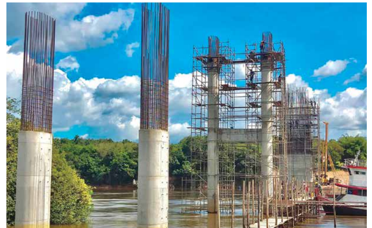
Ponte sobre o Rio Capim.
