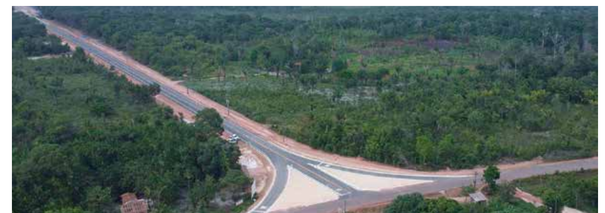
Construção da PA-467 com 19 quilômetros, entre PA-151 e Vila Curuçambaba em Cametá.
